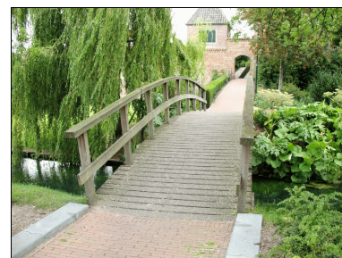
Ronde brug met een veel te steile helling !
