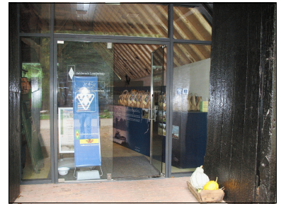
Glazen deuren met een goed zichtbare markering
