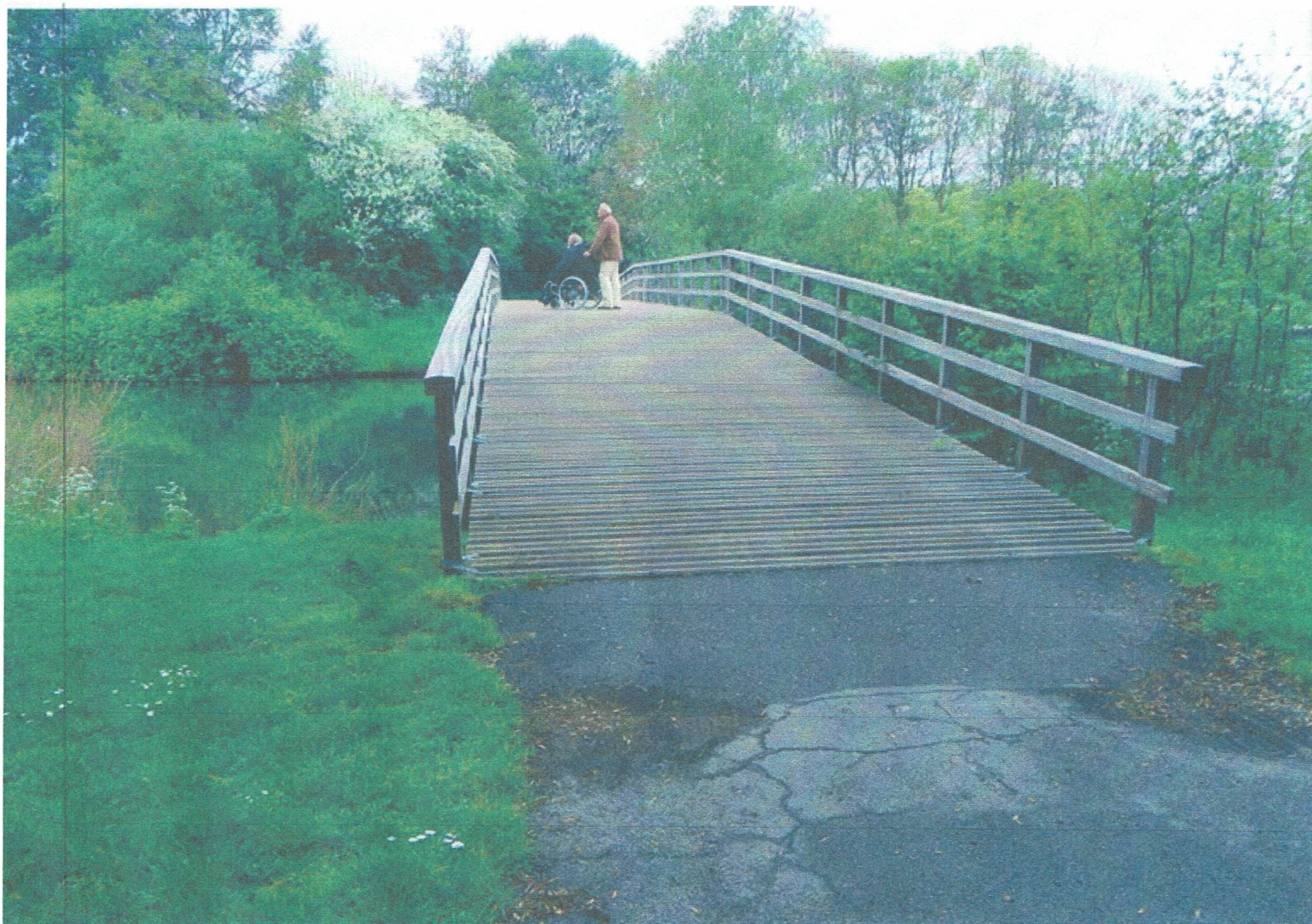
Een brug met een niet te steile helling en redelijk vlakke aansluiting op het wandelpad. (Dit vraagt wel regelmatig onderhoud)
